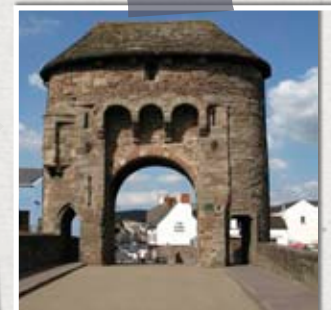
Pont Mynwy Monnow Bridge
